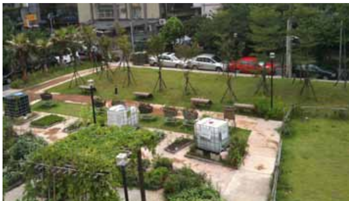
「臺北好好看計畫」-拆除老舊建物，施作景觀綠化工程
