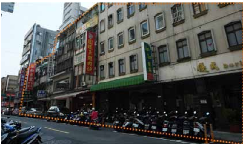
更新前屋況問題：耐震力不足、建物外觀不佳
